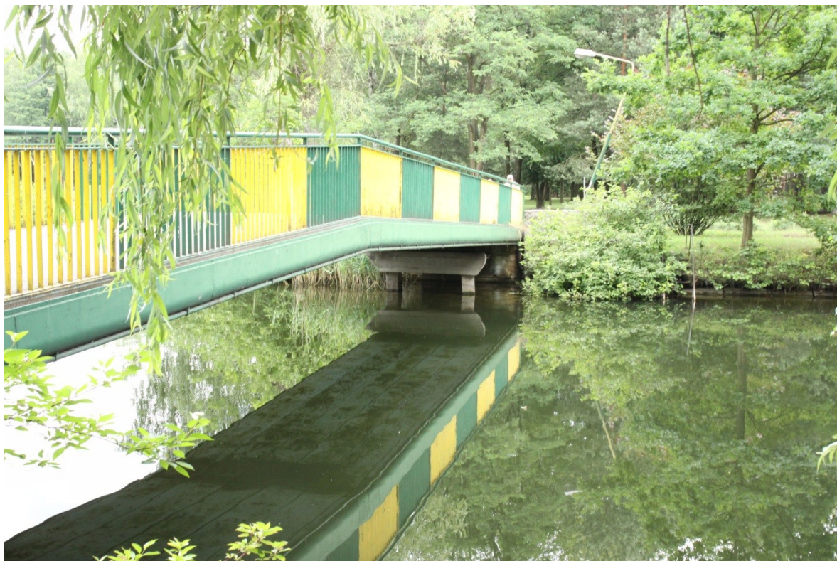
Fot. 2: Widok na kładkę od strony południowo-zachodniej
