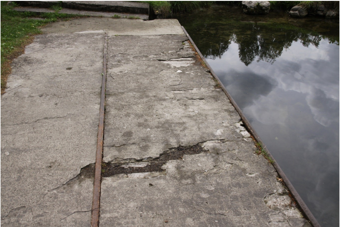
Fot. 14: Końcowy fragment nabrzeża od strony zachodniej
