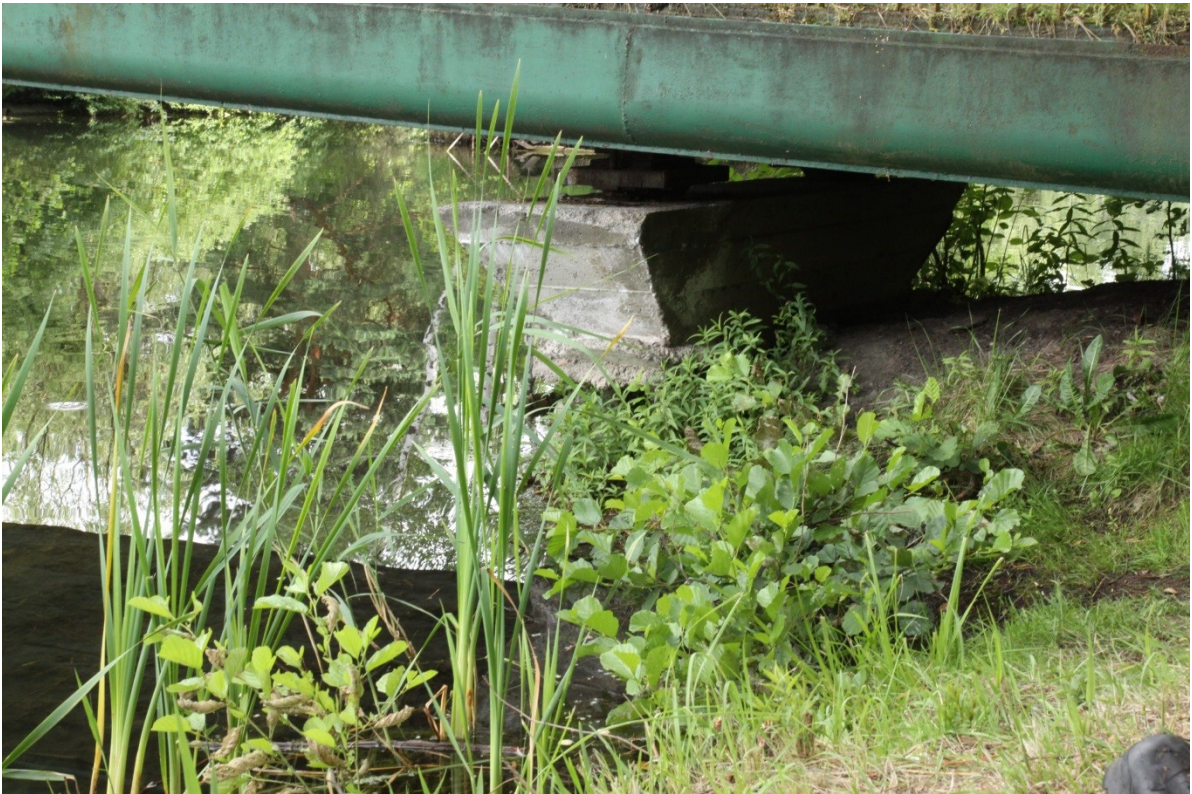
Fot. 9: Podpora żelbetowa po zachodniej stronie kładki
