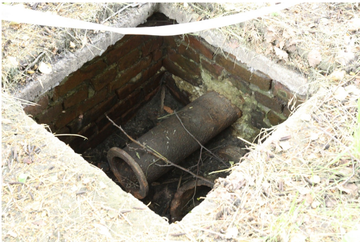
Fot. 19: Komora rurociągu zrzutowego
