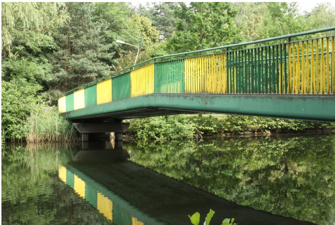
Fot. 1: Widok na kładkę od strony północno-zachodniej
