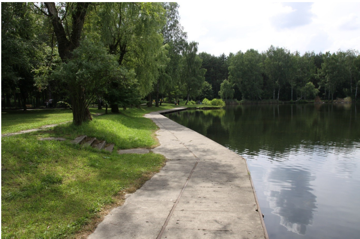
Fot. 13: Widok ogólny nabrzeża (od strony wschodniej)
