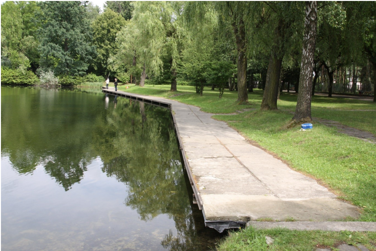
Fot. 12: Widok ogólny nabrzeża (od strony zachodniej)
