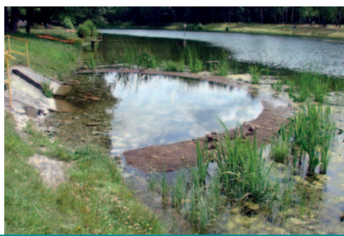
Rysunek 15. Strefa buforowa z barierą biogeochemiczną do podczyszczania wód odprowadzanych bezpośrednio do zbiornika wodnego — schemat i przykład pilotażowego zastosowania na stawach w Arturówku w Łodzi
