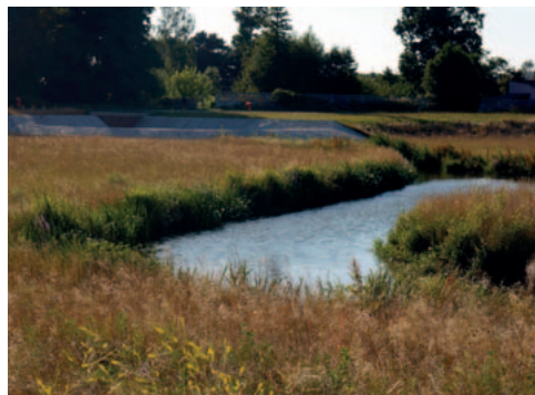
Rysunek 11. Suche zbiorniki ze strefą stałego przepływu: zbiornik na rzece Sokółówce w Łodzi i w Virginii, w Stanach Zjednoczonych
