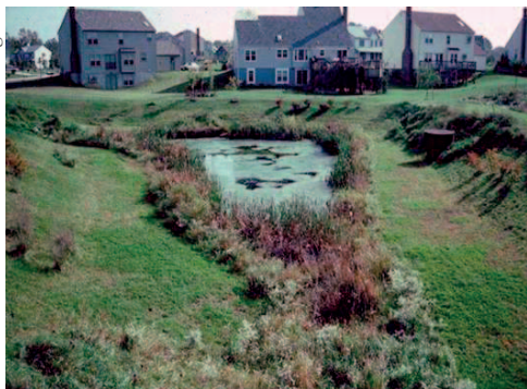
Rysunek 11. Suche zbiorniki ze strefą stałego przepływu: zbiornik na rzece Sokółówce w Łodzi i w Virginii, w Stanach Zjednoczonych
