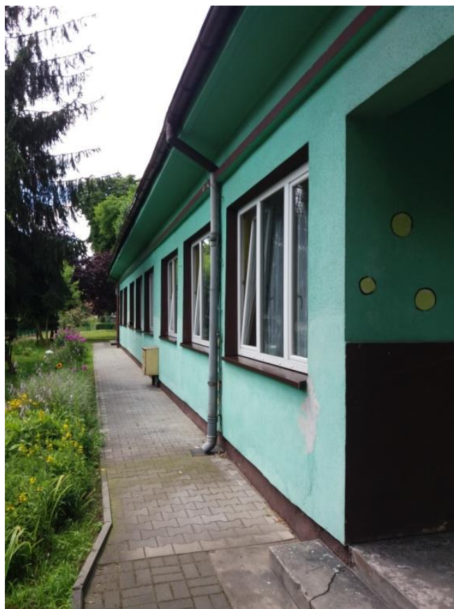
Rysunek 18. Widok na system odprowadzania wód opadowych do gruntu. (Źródło: własne).
