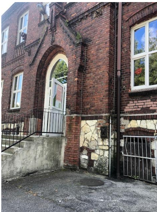
Rysunek 8. Schody przeznaczone do remontu, widok na rurę spustową do kanalizacji deszczowej oraz wąż do studzienki. Proponowane miejsce posadowienia pierwszego ogrodu deszczowego. (Źródło: własne)
