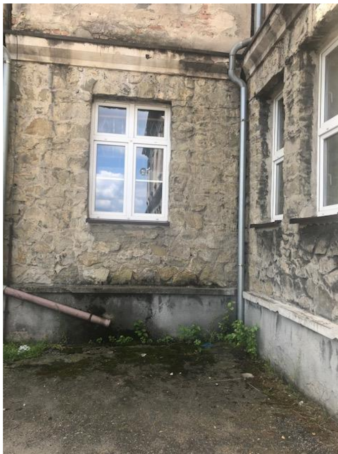
Rysunek 4. Miejsce lokalizacji ogrodu deszczowego. Widok na dwie rury spustowe zasilające projektowany ogród.
