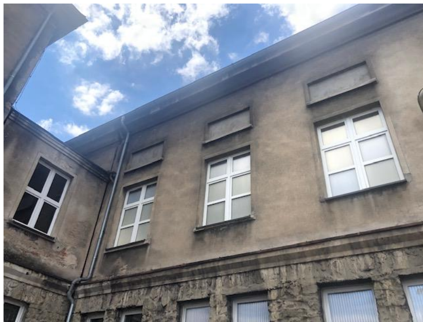
Rysunek 5. Widok na system odprowadzania wód opadowych z dachu budynku oraz na stan elewacji. (Źródło: własne).
