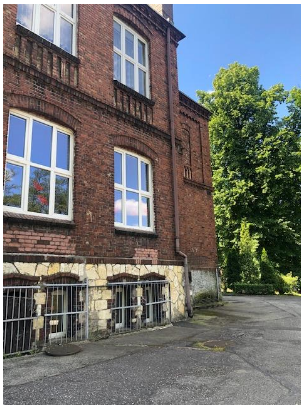
Rysunek 7. Elewacja budynku oraz system odprowadzania wód opadowych. (Źródło: własne)
