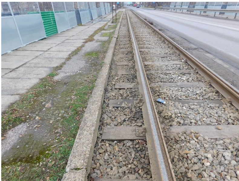
Fot. 25 Widok ogólny na torowisko od strony Mysłowic.
