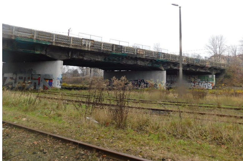
Fot. 1 Widok wiaduktu od strony prawej (wschodniej).
