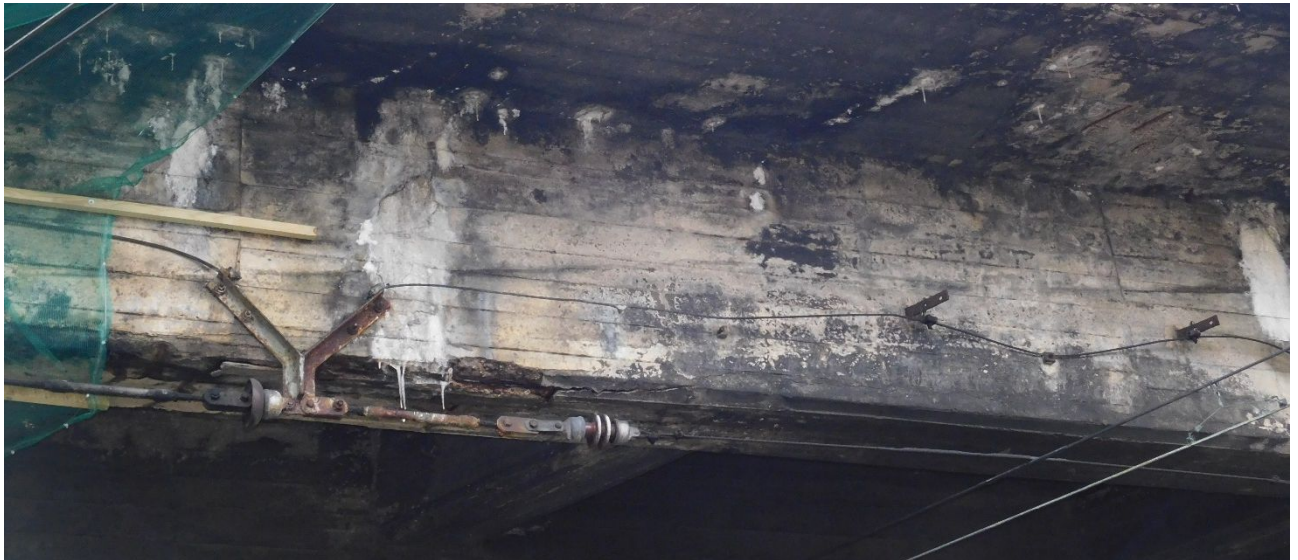
Fot. 36 Widok na uszynienie i elementy zamocowania trakcji kolejowej zamontowane na belce skrajnej przęśla środkowego.
