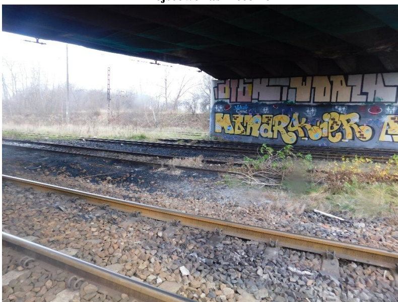
Fot. 39 Widok na teren pod przęsłem przedskrajnym.
