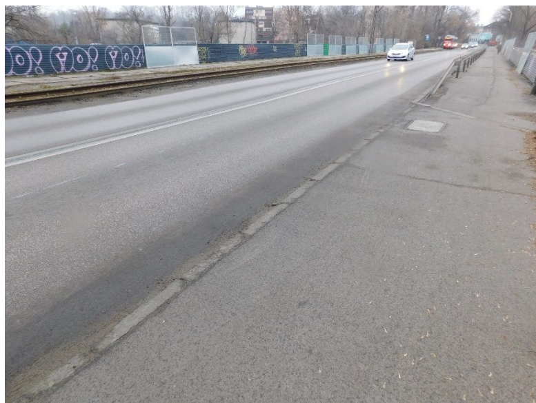
Fot. 3 Widok na część przejazdową obiektu
