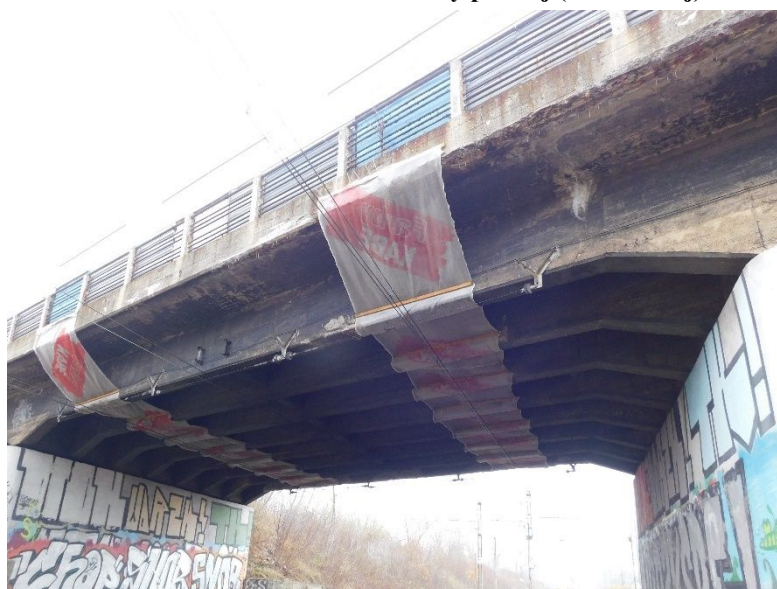
Fot. 2 Widok konstrukcji nośnej przęsła przedskrajnego od spodu.
