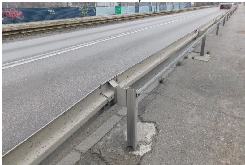
Fot. 32 Widok na barierę energochłonną na chodniku lewym. Widoczny zadowalający stan elementu.
