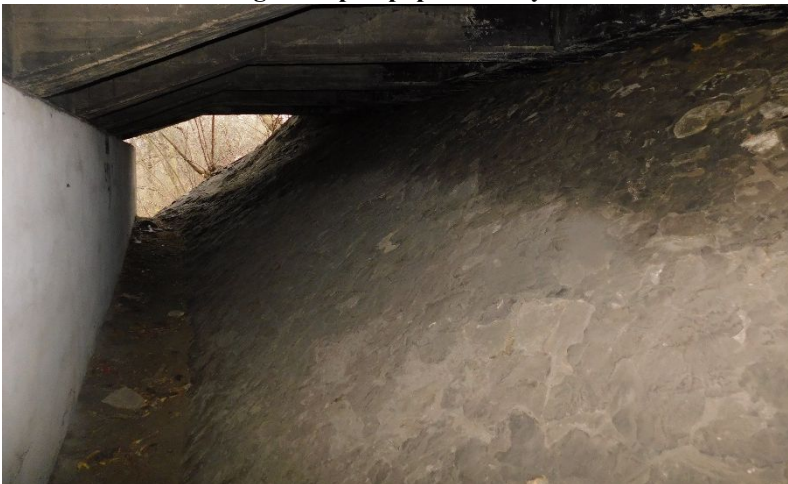
Fot. 34 Widok na umocnienie skarpy pod przeslem skrajnym od strony Myslowic.
