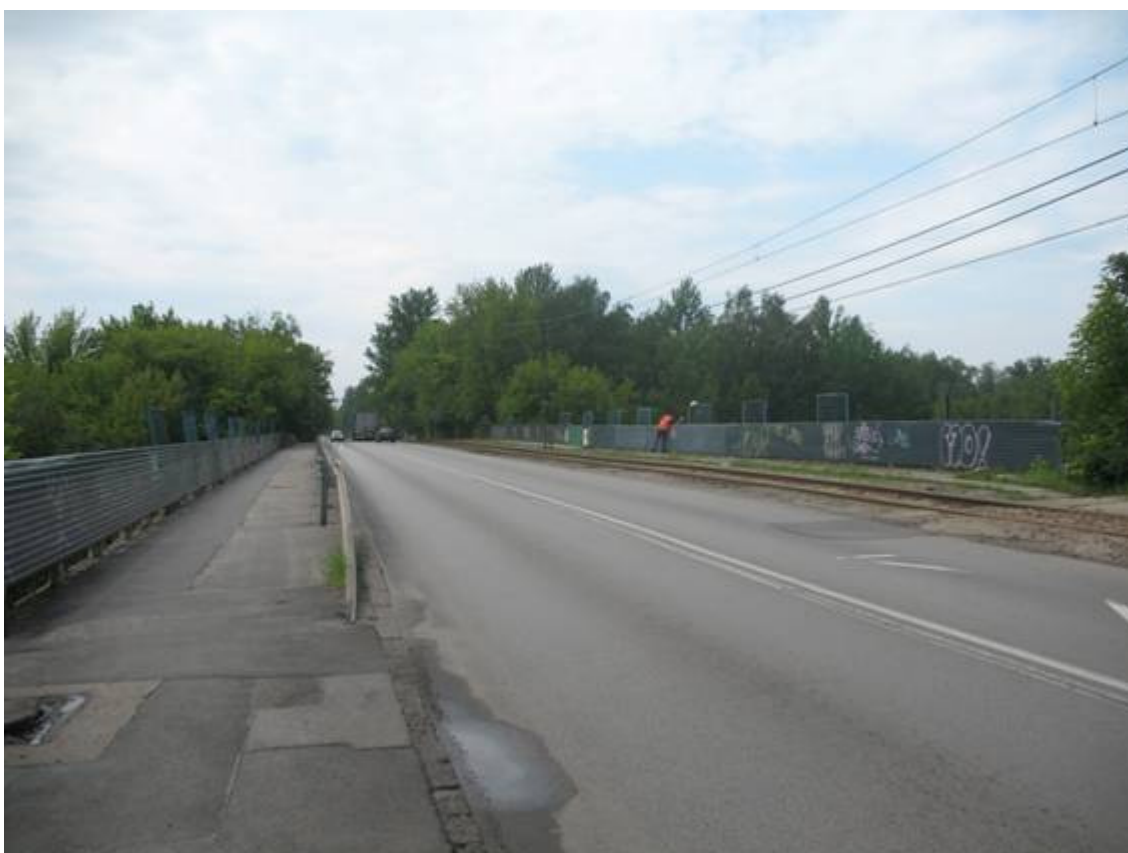
Fot. 4. Widok pomostu na dojazd od strony północnej.
