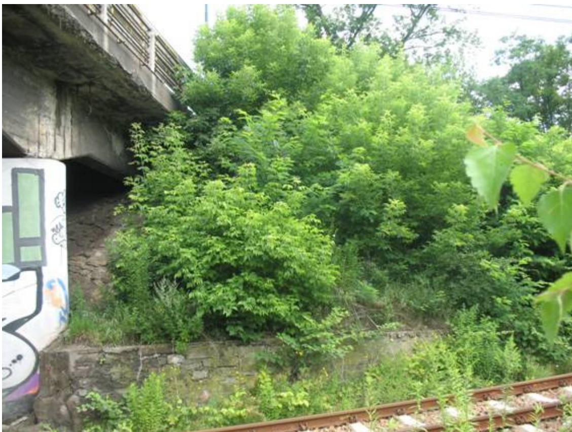
Fot. 5. Widok na stożek skarpowy od strony północno-wschodniej. Wegetacja roślin na stożku skarpowym.
