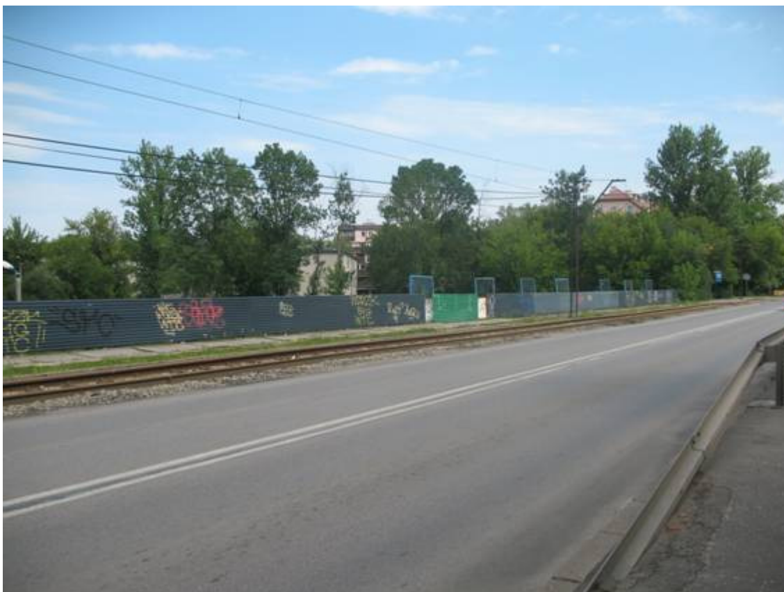
Fot. 3. Widok pomostu na dojazd od strony południowej.
