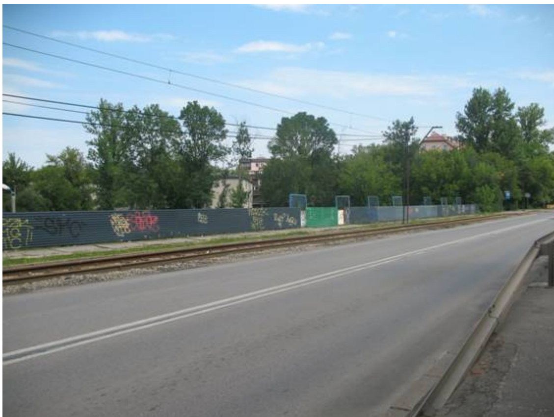
Fot. 3. Widok pomostu od strony południowej
