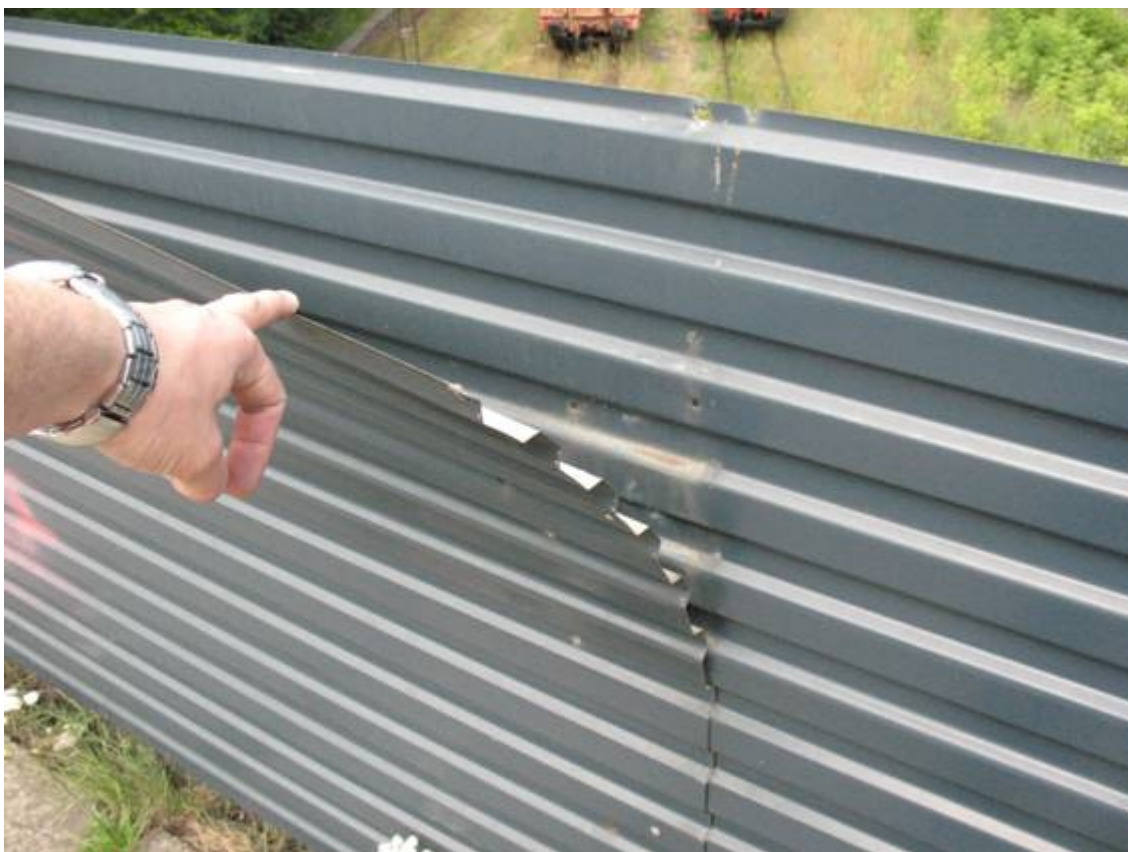
Fot. 35. Blacha trapezowa, brak mocowań.
