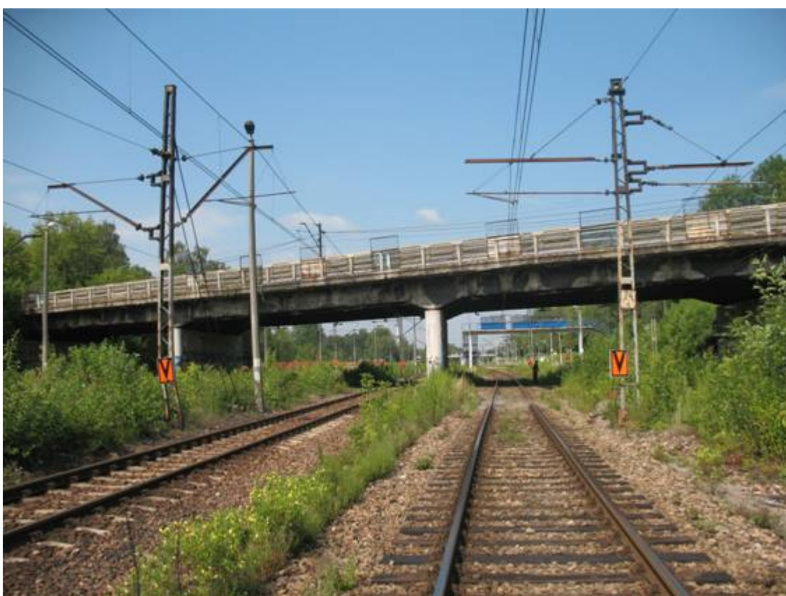
Fot. 2. Widok obiektu z boku od strony wschodniej.
