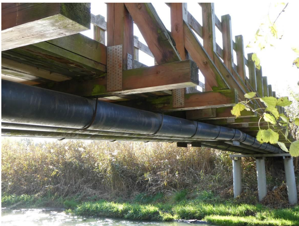
Fot. 5. Widok na obiekt z boku. Wykwity na elementach drewnianych.
