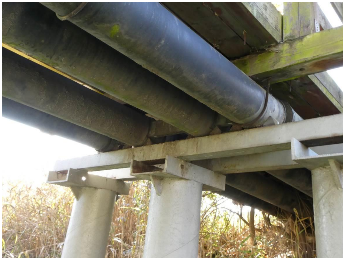
Fot. 7. Widok na podporę pośrednią. Brak uszkodzeń.
