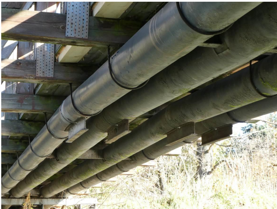
Fot. 4. Widok na ustrój nośny. Wykwity na powierzchni.
