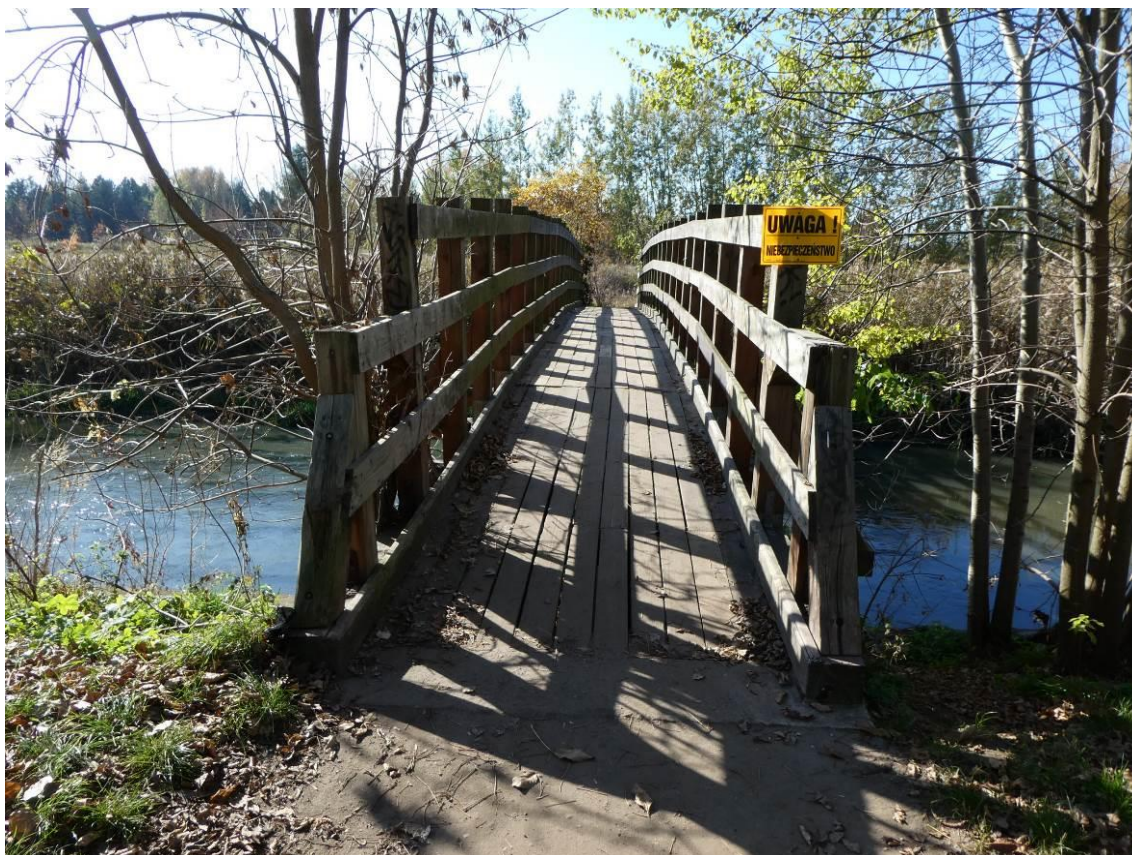
Fot. 1. Widok na obiekt. Na nawierzchni na dojściu do obiektu wegetacja roślin.
