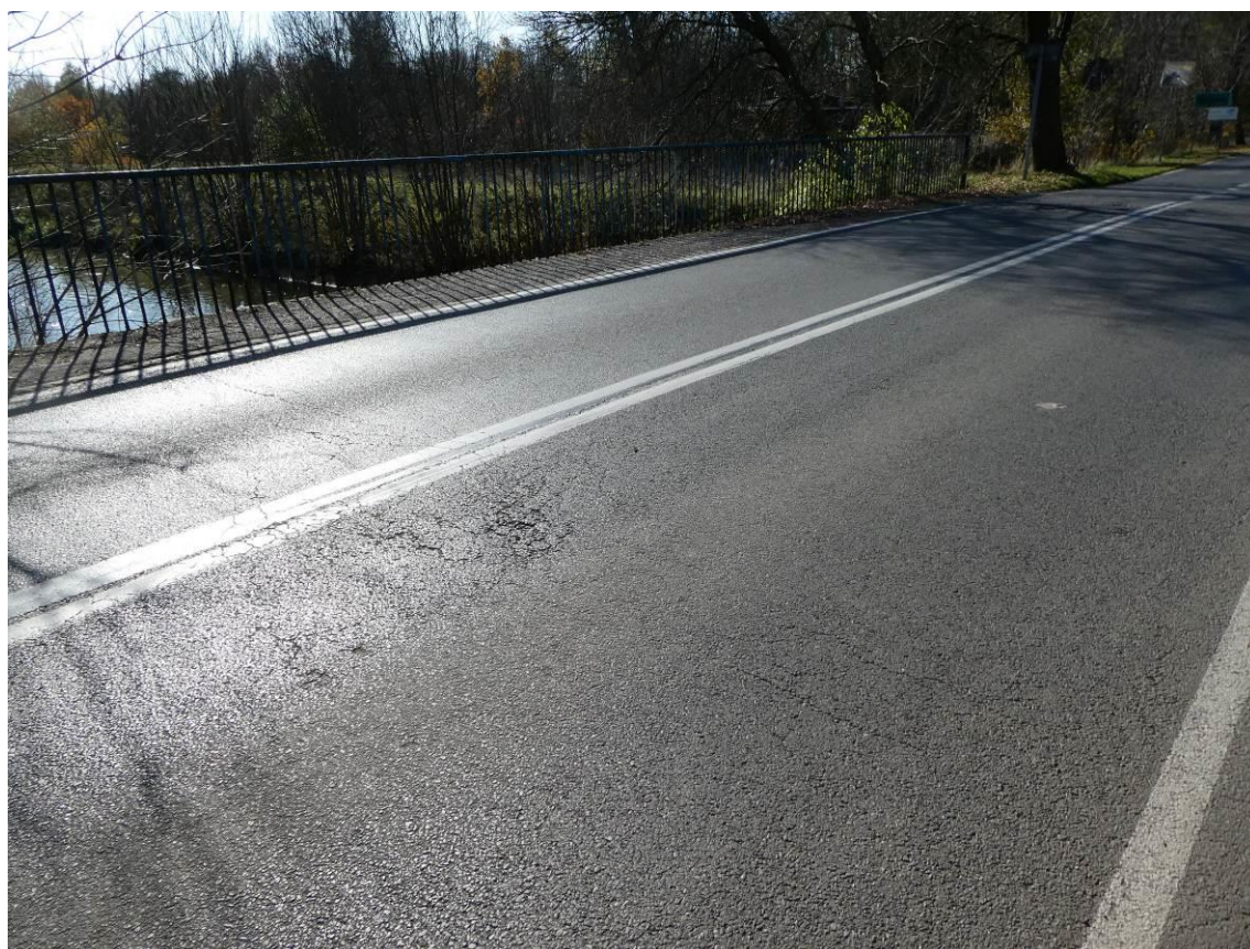
Fot. 2. Widok na nawierzchnię. Spękanie siatkowe nawierzchni.
