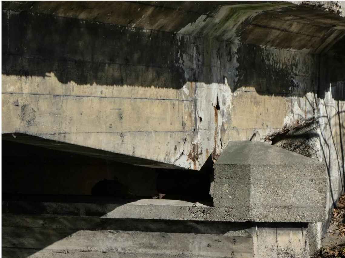
Fot. 7. Widok z boku. Korozja betonu oraz stali zbrojeniowej dźwigara nad podporą pośrednią. Na dźwigarze znaczne zacieki i wykwyty, lokalne ubytki betonu.
