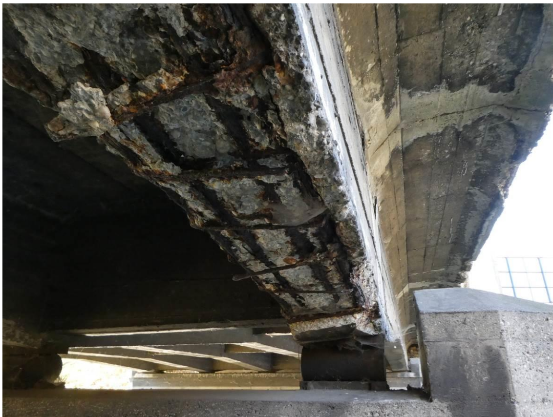
Fot. 5. Widok na dźwigar skrajny. Występuje degradacja oraz znaczne ubytki betonu. Odspojenie otuliny spowodowało korozję prętów zbrojeniowych.
