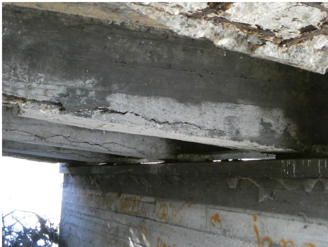
Fot. 9. Głębokie zarysowanie dźwigarów w rejonie podparcia przęsła wspornikowego.
