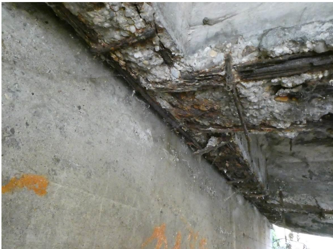
Fot. 8. Widok na dźwigar w strefie wspornikowej. Występuje degradacja betonu oraz stali zbrojeniowej.
