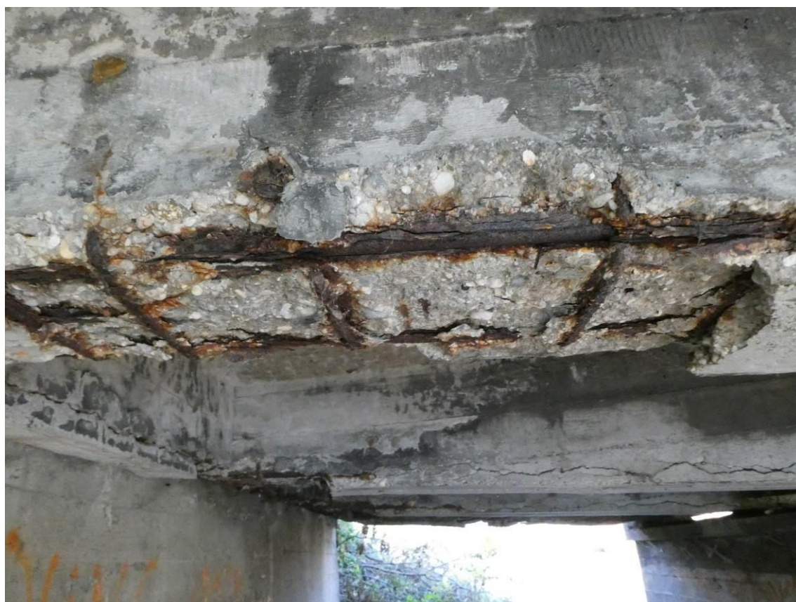
Fot. 10. Znaczne ubytki betonu oraz korozja stali zbrojeniowej na dźwigarach, na przęśle wspornikowym.
