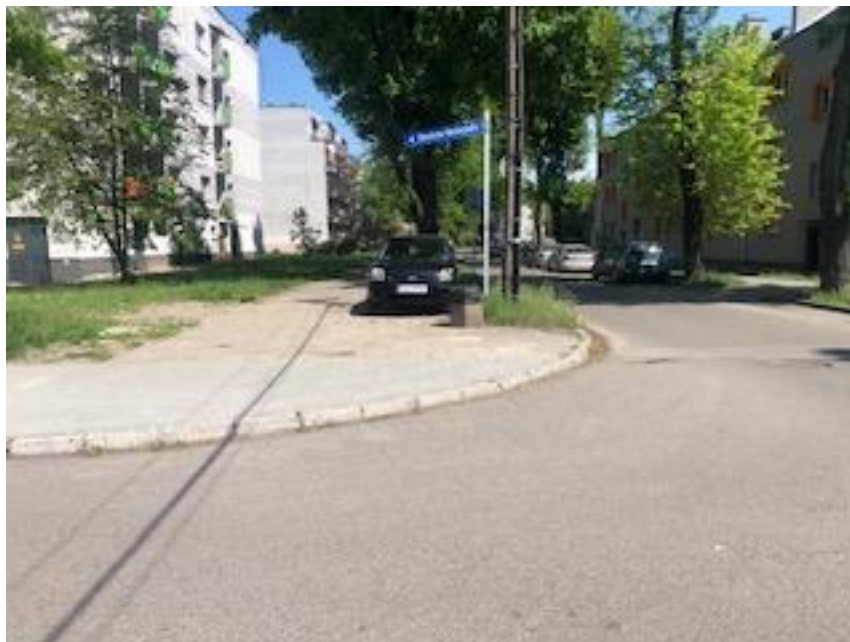
Rysunek 25. Koniec opracowania północnej strony inwestycji, połączenie z istniejącą kostką. Widok w kierunku Szkoły Podstawowej nr 36.
