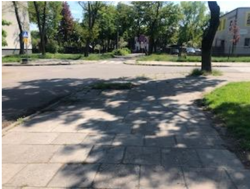
Rysunek 9. Istniejący chodnik w okolicy przejścia dla pieszych, skrzyżowanie z ul. Komandosów, widok w kierunku południowym.
