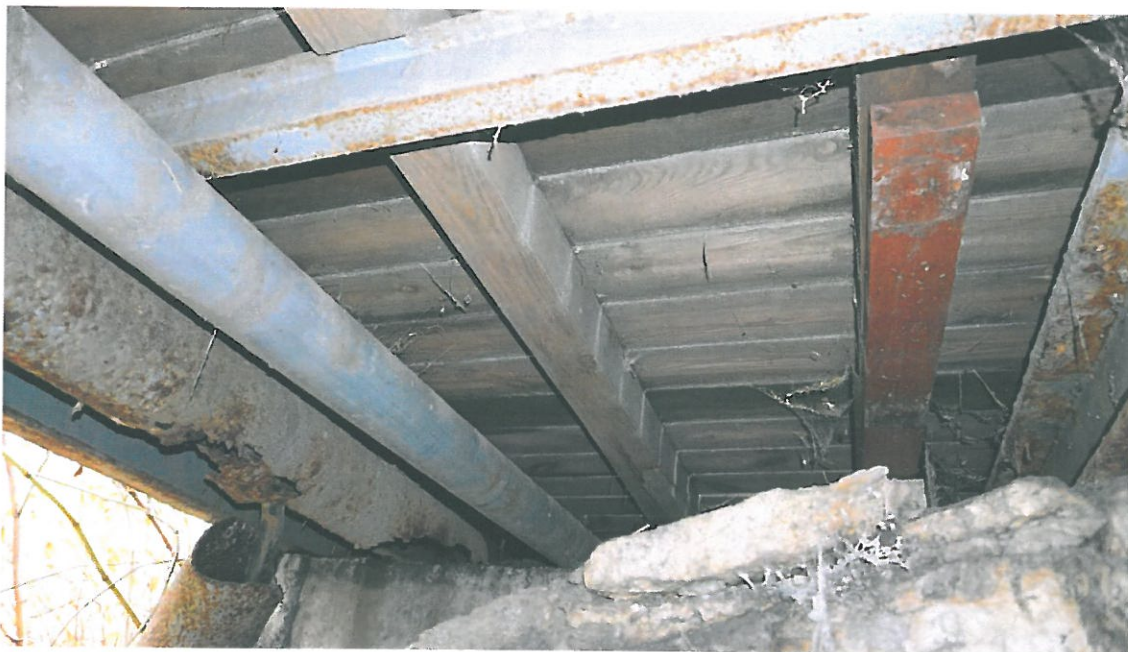
Fot. 15 Widok konstrukcji kładki od spodu
