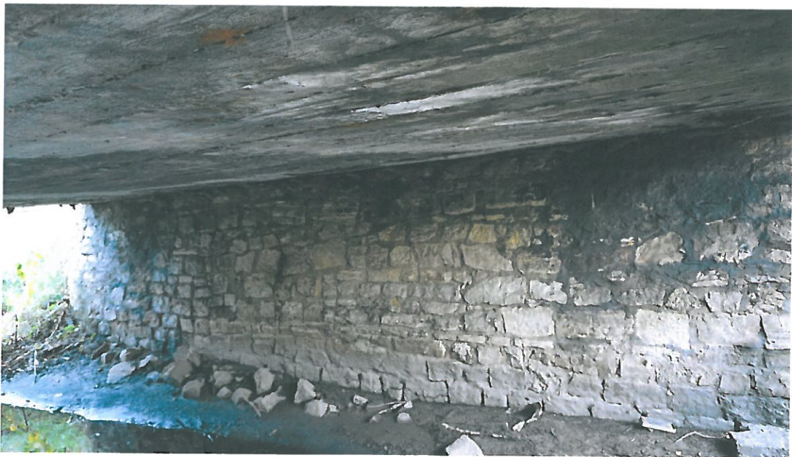
Fot. 14 Widok ustroju nośnego i podpór istniejącego mostu.
