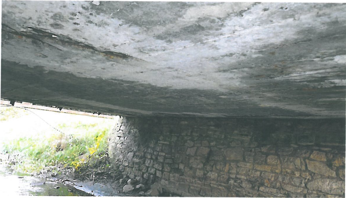
Fot. 13 Widok ustroju nośnego i podpór istniejącego mostu.
