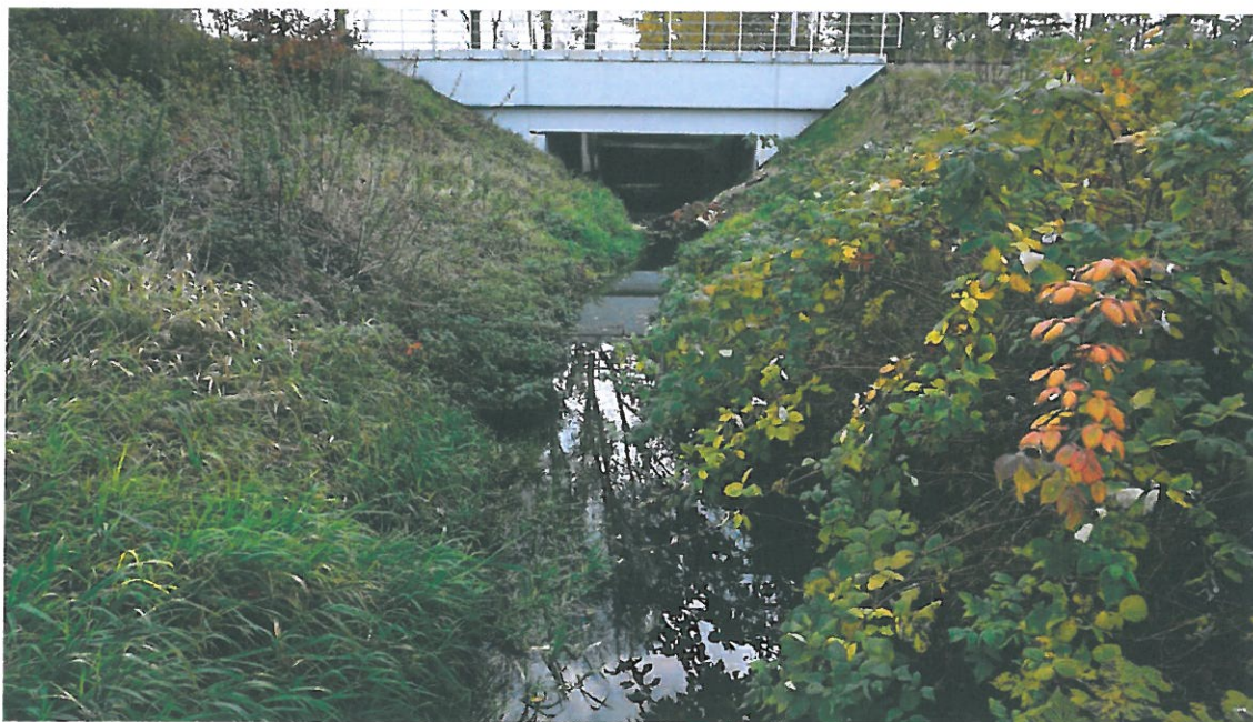
Fot. 8 Widok koryta ciek - rowu Mortimerowskiego od strony wody dolnej.
