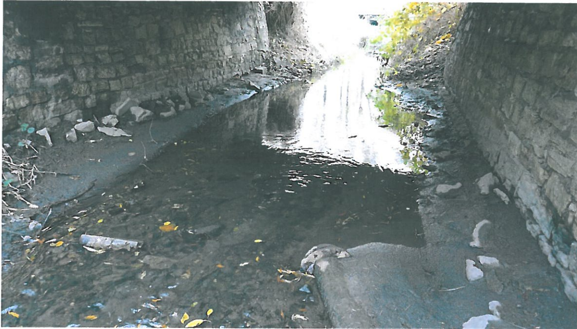
Fot. 11 Widok przestrzeni podmostowej - koryta cieku.
