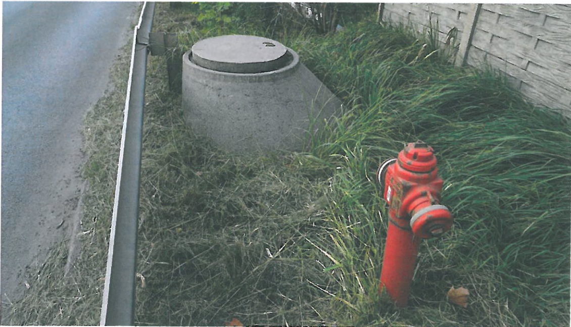
Fot. 4 Kolidująca infrastruktura techniczna od strony wody górnej.
