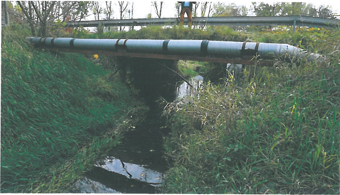
Fot. 9 Widok istniejącego mostu z boku - od strony wody górnej.
