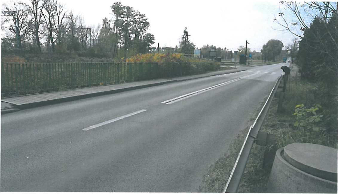
Fot. 3 Widok pomostu istniejącego mostu.
