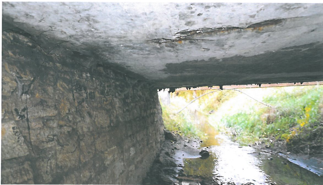
Fot. 12 Widok ustroju nośnego i podpór istniejącego mostu.
