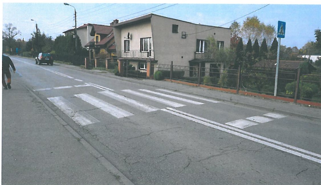
Fot. 2 Widok dojazdu istniejącego do mostu od strony ul. Wiejskiej.
