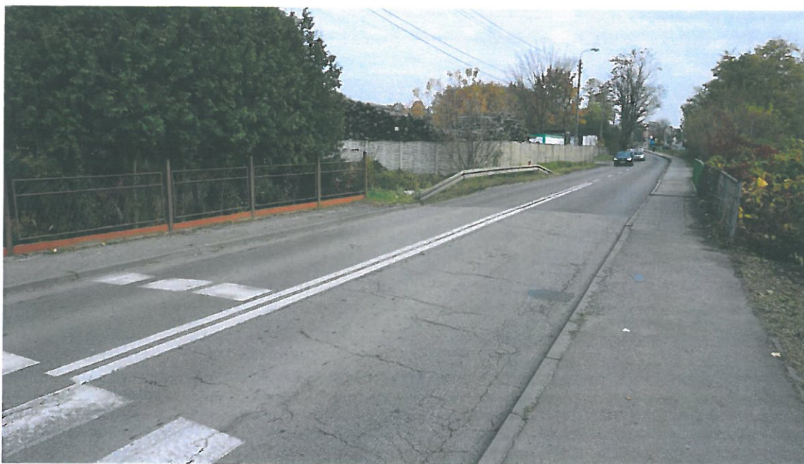
Fot. 1. Widok dojazdu do istniejącego mostu od strony ul. Wiejskiej.
