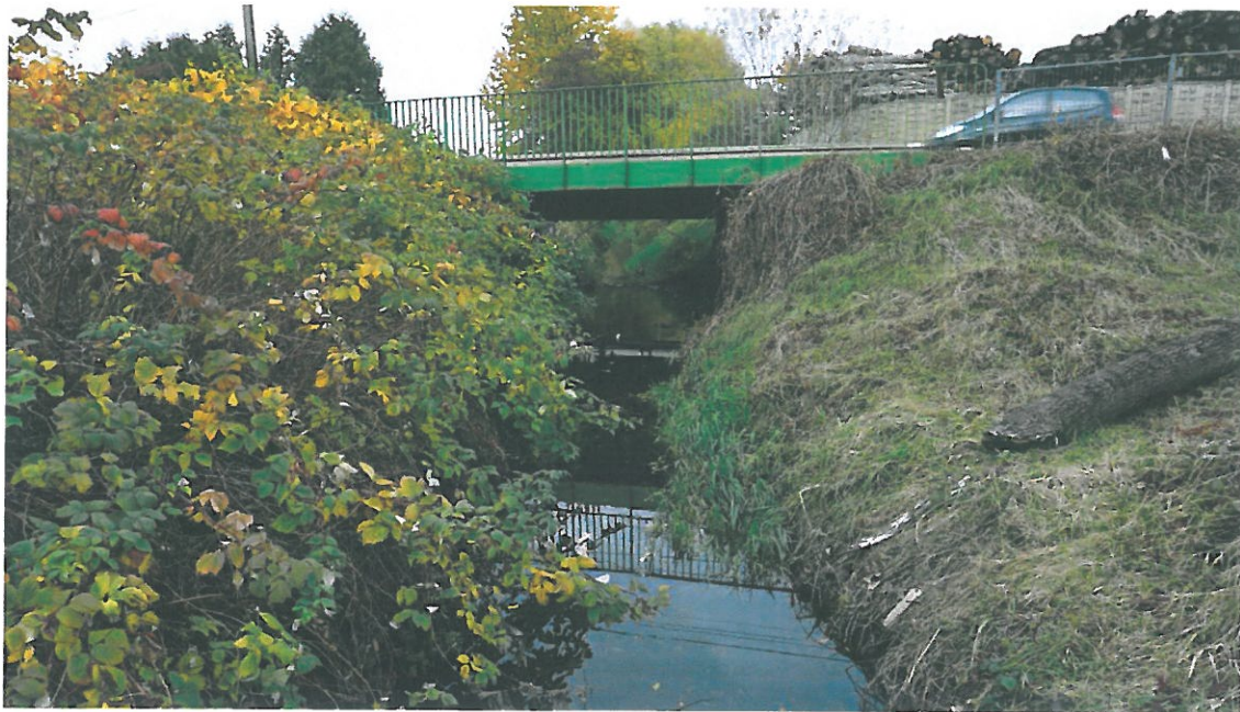
Fot. 7 Widok istniejącego mostu z boku - od strony wody dolnej.
