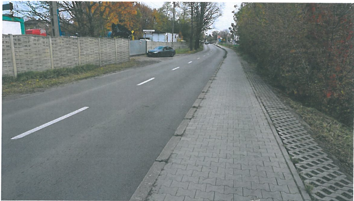
Fot. 6 Widok dojazdu do istniejącego mostu od strony ul. Głównej.
