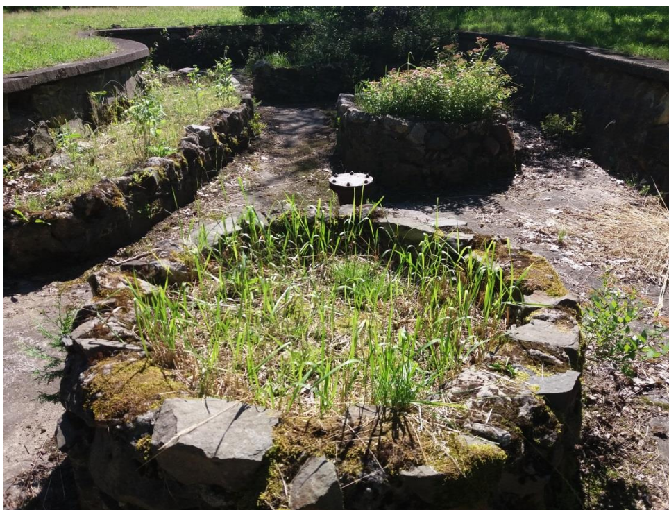
Rysunek 5. Dno fontanny, widoczne wyspy z kamieni na zaprawie. (Źródło: własne).
