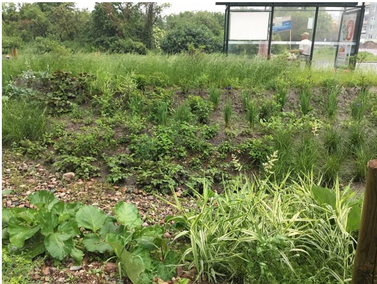
Rysunek 15. Ogród deszczowy w gruncie po prawidłowym posadzeniu i ukorzeniu roślin (Źródło: www.gdansk.pl )
