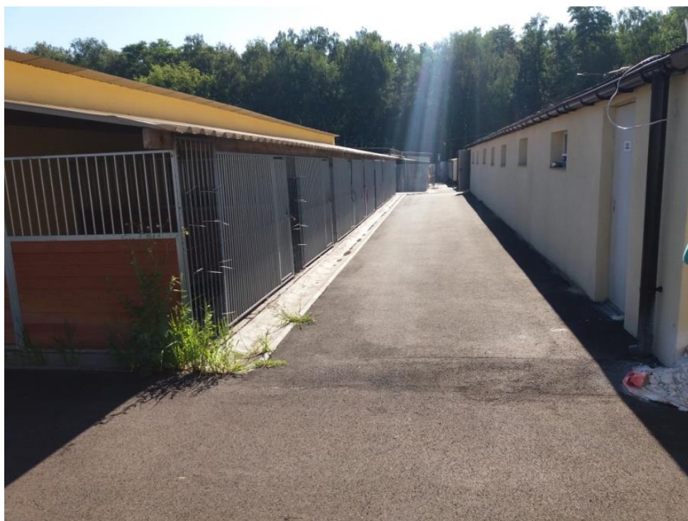
Rysunek 3. Widok na jeden z budynków, w którym przebywają bezdomne psy. Widok na system odprowadzania nieczystości za pomocą koryt otwartych. (Źródło: własne).
