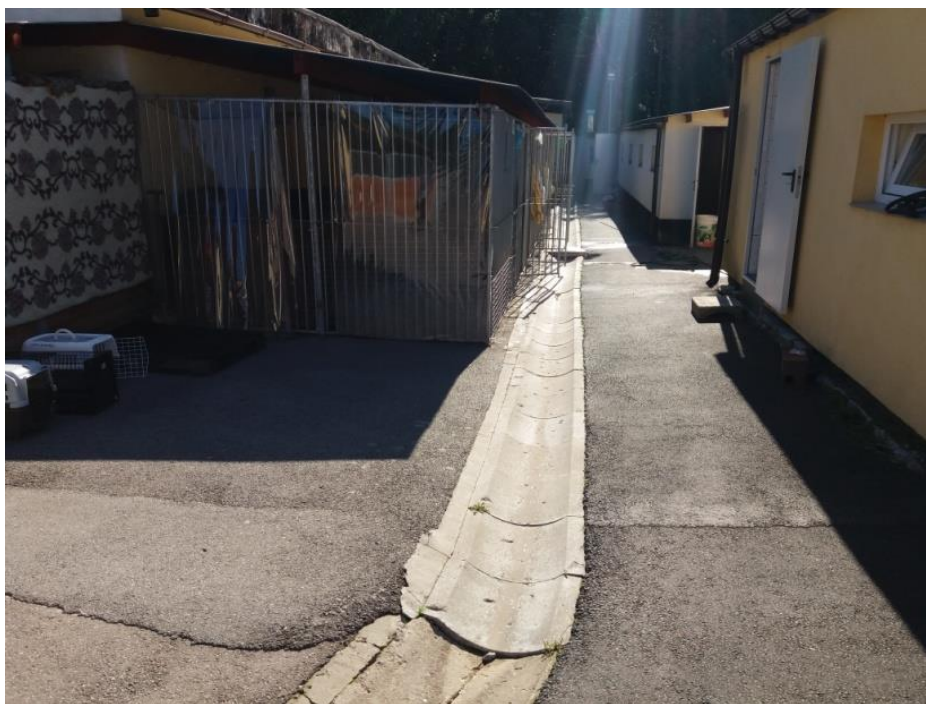
Rysunek 3. System odprowadzania nieczystości z boksów oraz widok rury spustowej sąsiadującego budynku z odprowadzeniem na teren utwardzony. (Źródło: własne).
