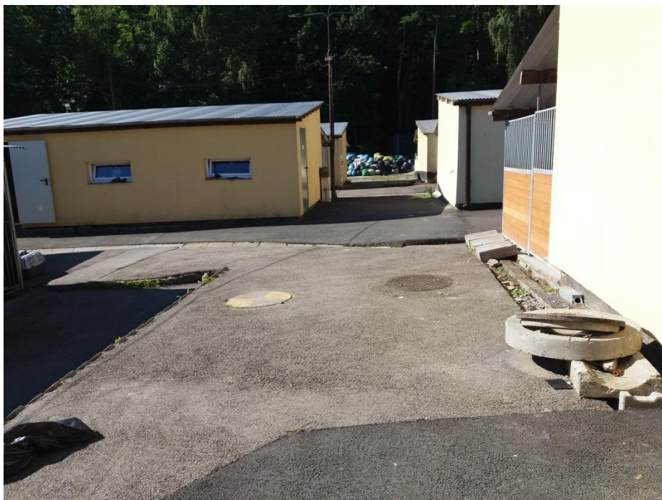
Rysunek 9. Widok na teren utwardzony wokół budynków , widoczna studnia kanalizacji sanitarnej z systemu odprowadzania nieczystości z boksów oraz studnia wodomierzowa. (Źródło: własne).
