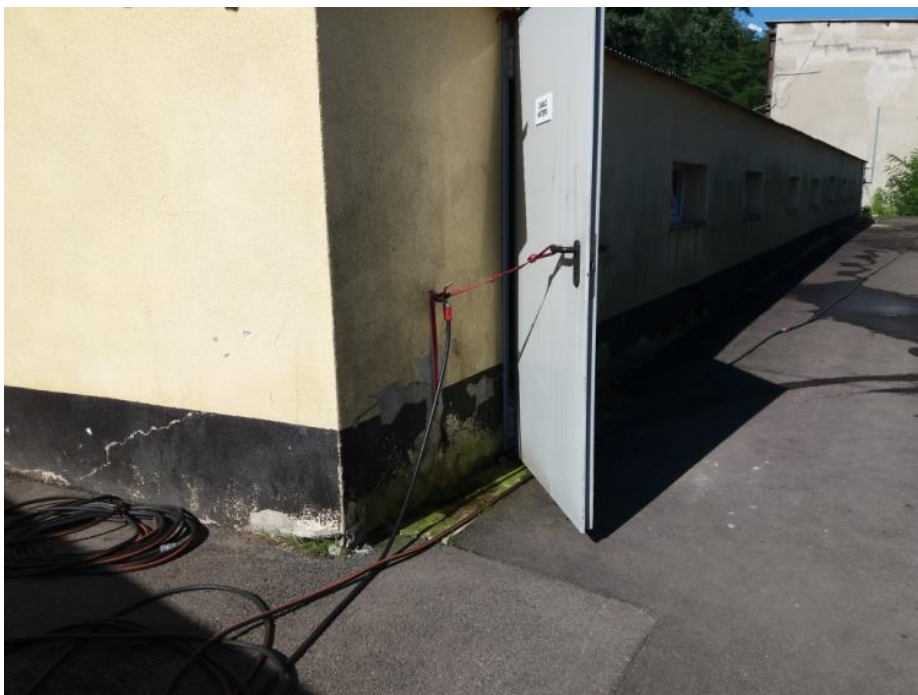
Rysunek 4. Widok na punkt poboru bieżącej wody jednego z budynków schroniska. (Źródło: własne).
