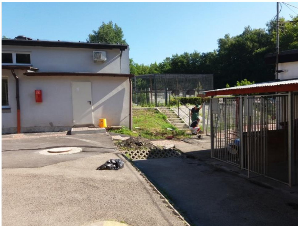
Rysunek 2. Widok na proponowane miejsce posadowienia zbiornika na wodę opadową. Boksy widoczne na fotografii po prawej stronie zostały przeznaczone do likwidacji. (Źródło: własne).
