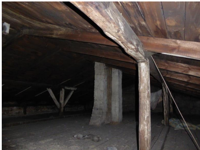
9. Poddasze użytkowe budynek mieszkalny.
