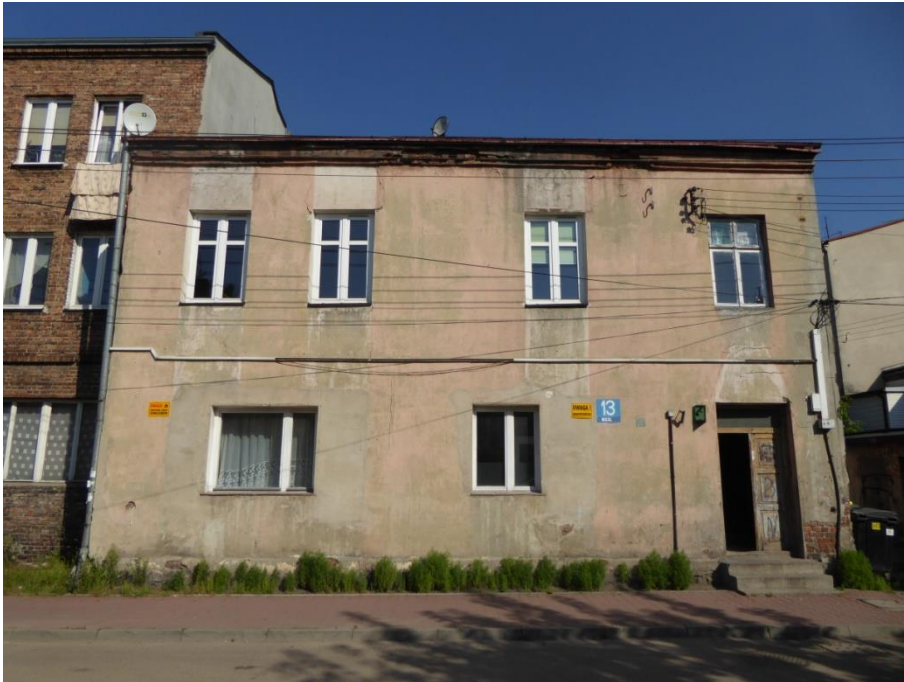
1. Ściana południowo-wschodnia budynku mieszkalnego.
