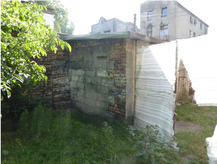
5. Ściana północno-zachodnia komórek lokatorskich.
