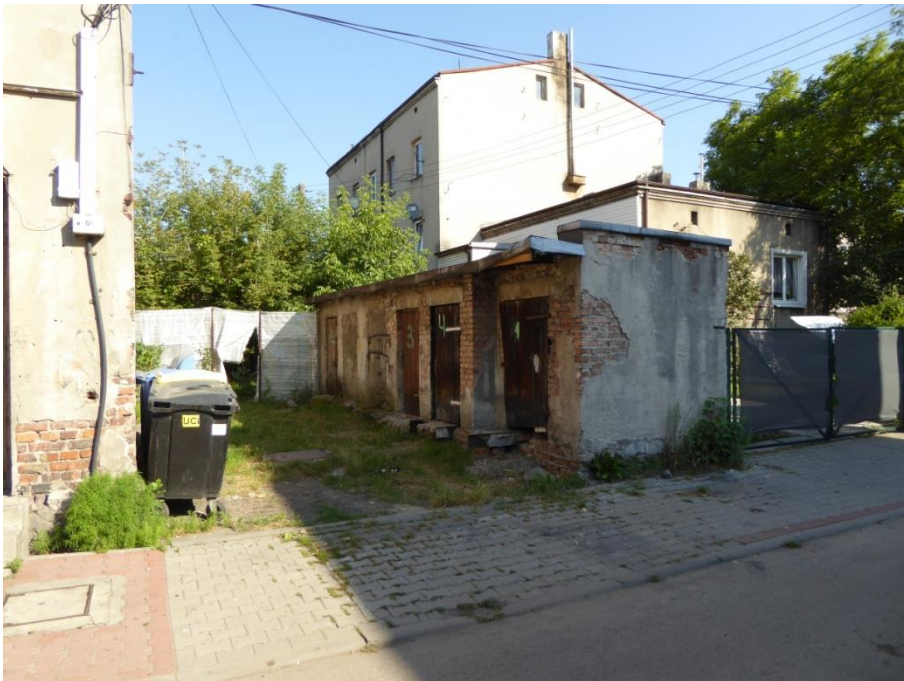
6. Ściana południowo-zachodnia oraz południowo-wschodnia komórek lokatorskich.
