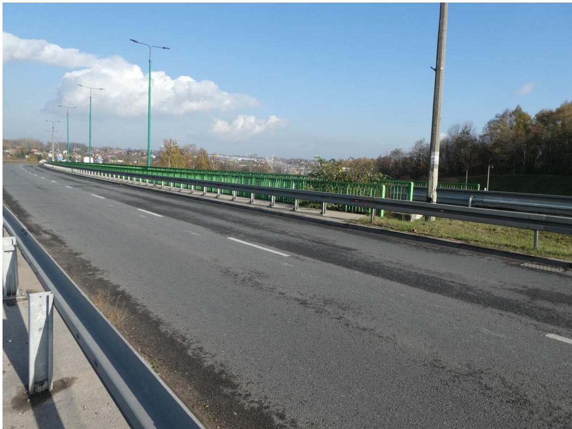
Fot. 4. Nawierzchnia na obiekcie i dojeździe. Brak uszkodzeń. Bariery w stanie odpowiednim.
