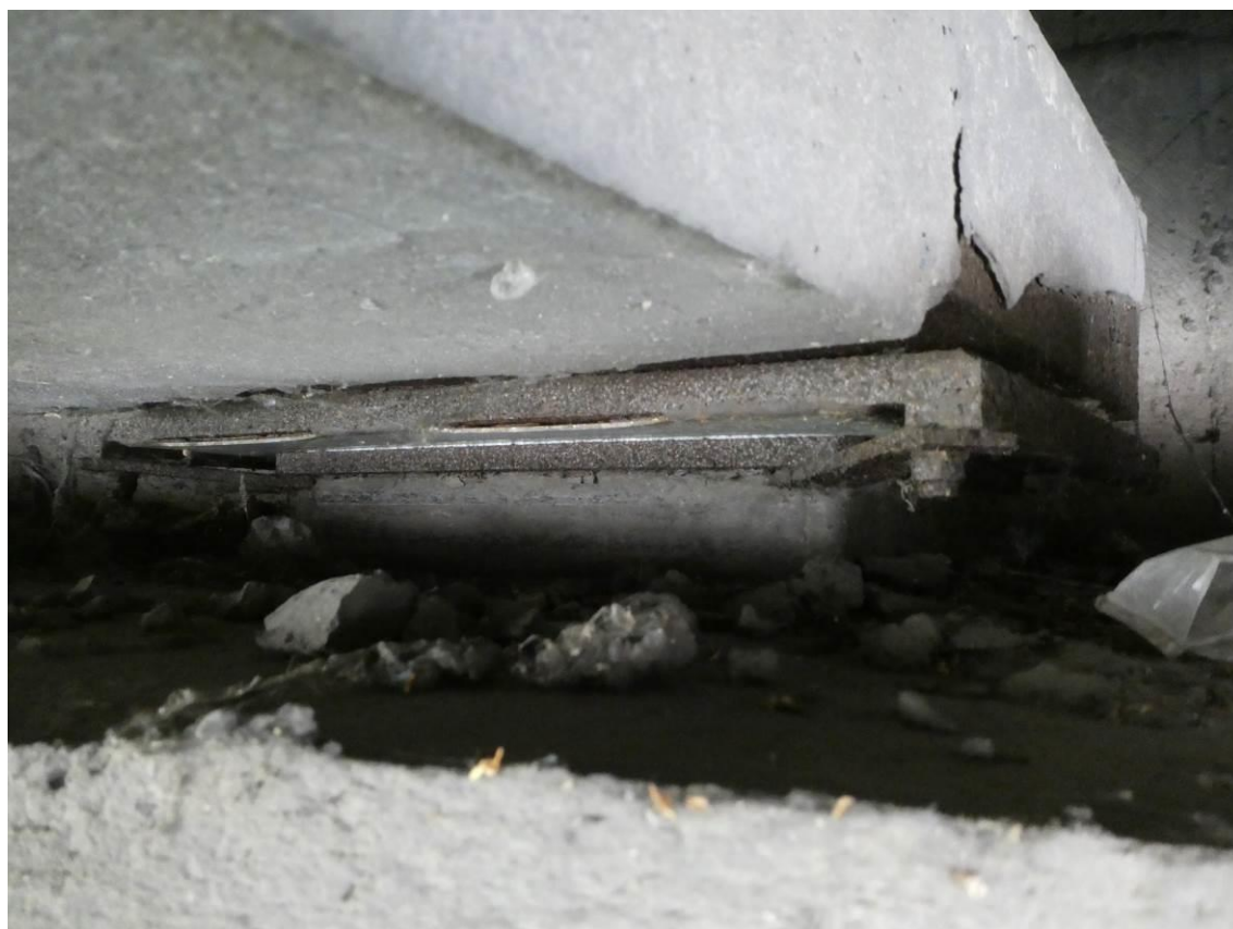
Fot. 3. Widok na łożysko elastomerowe.
