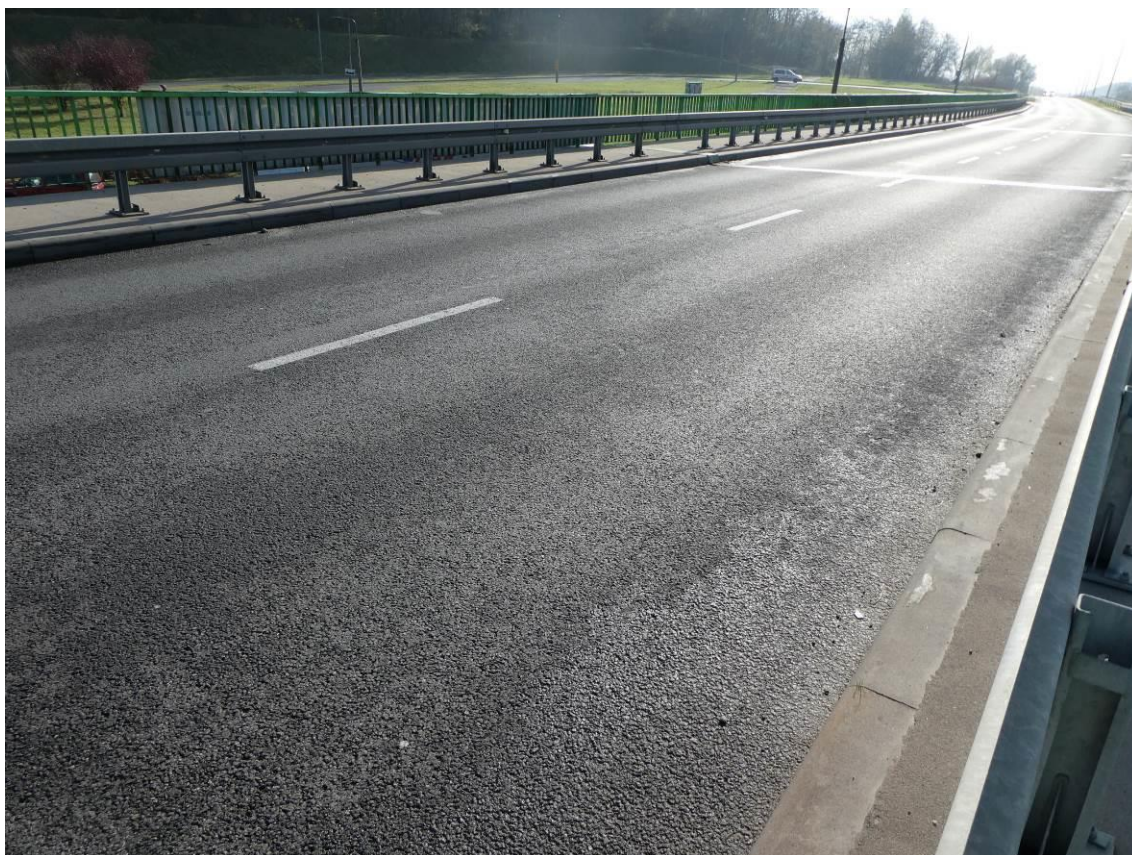
Fot. 1. Nawierzchnia na obiekcie. Brak uszkodzeń.
