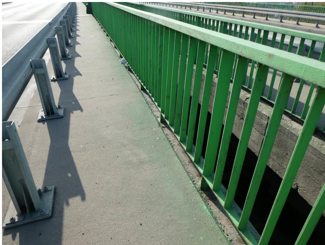
Fot. 5. Widok na chodnik, bariery i balustrady. Stan odpowiedni.
