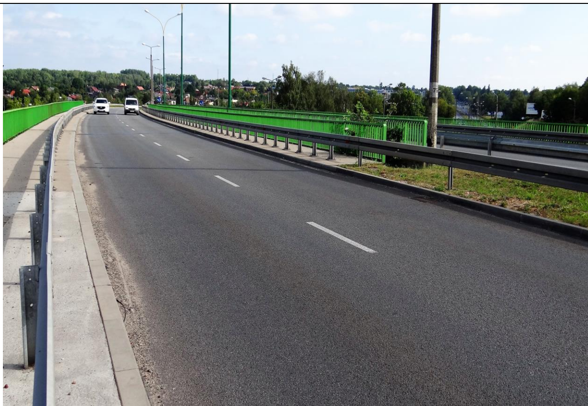
Fot. nr 2. Jezdnia na wiadukcie.
