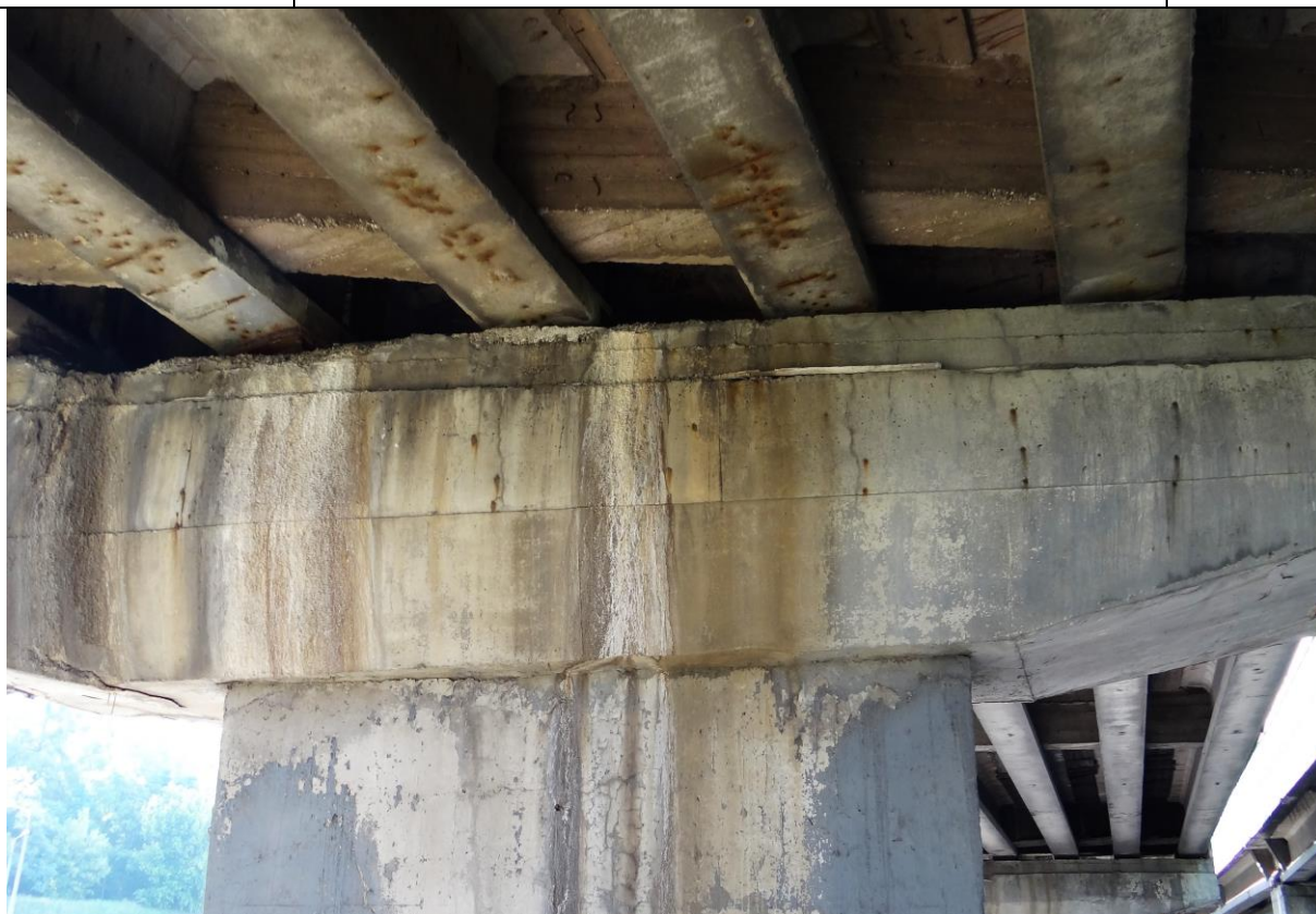
Fot. nr 3. Oczep filara, spód przęsła.
