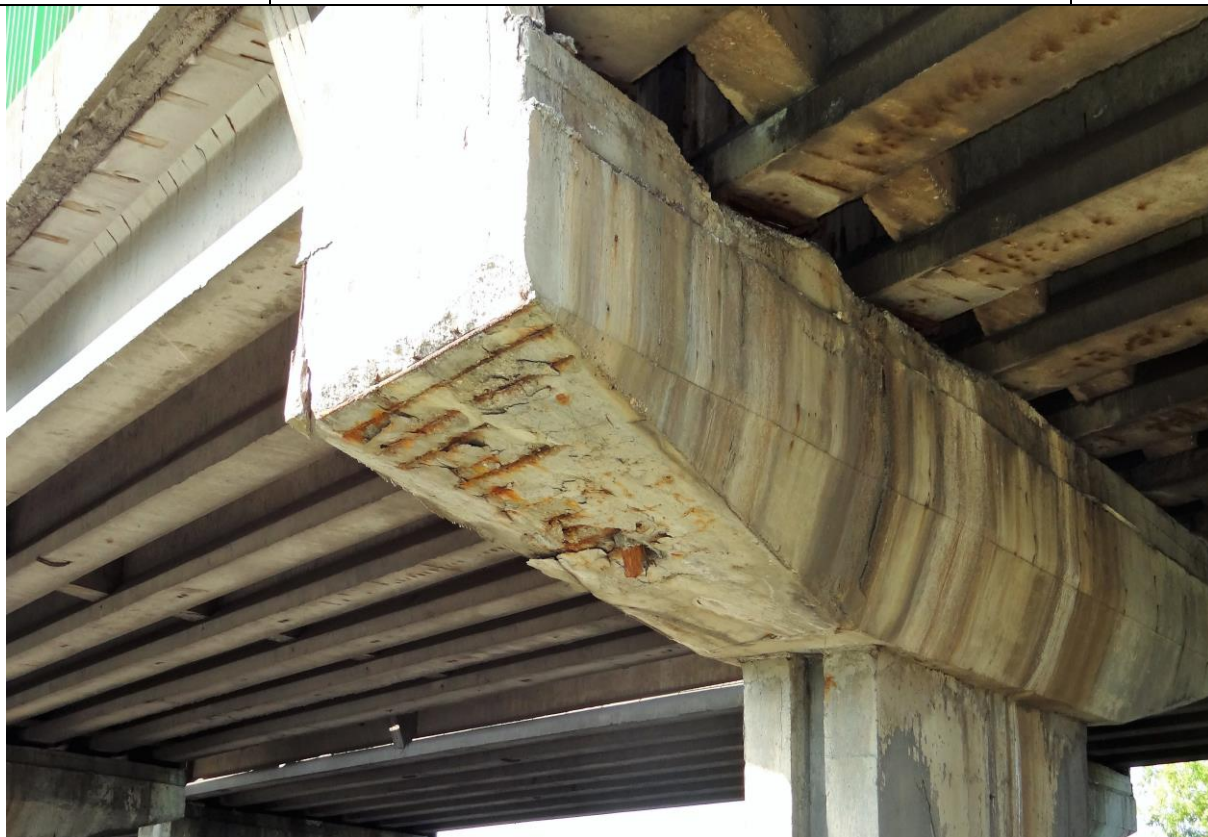
Fot. nr 3. Oczepek filara, spód przęsła.
