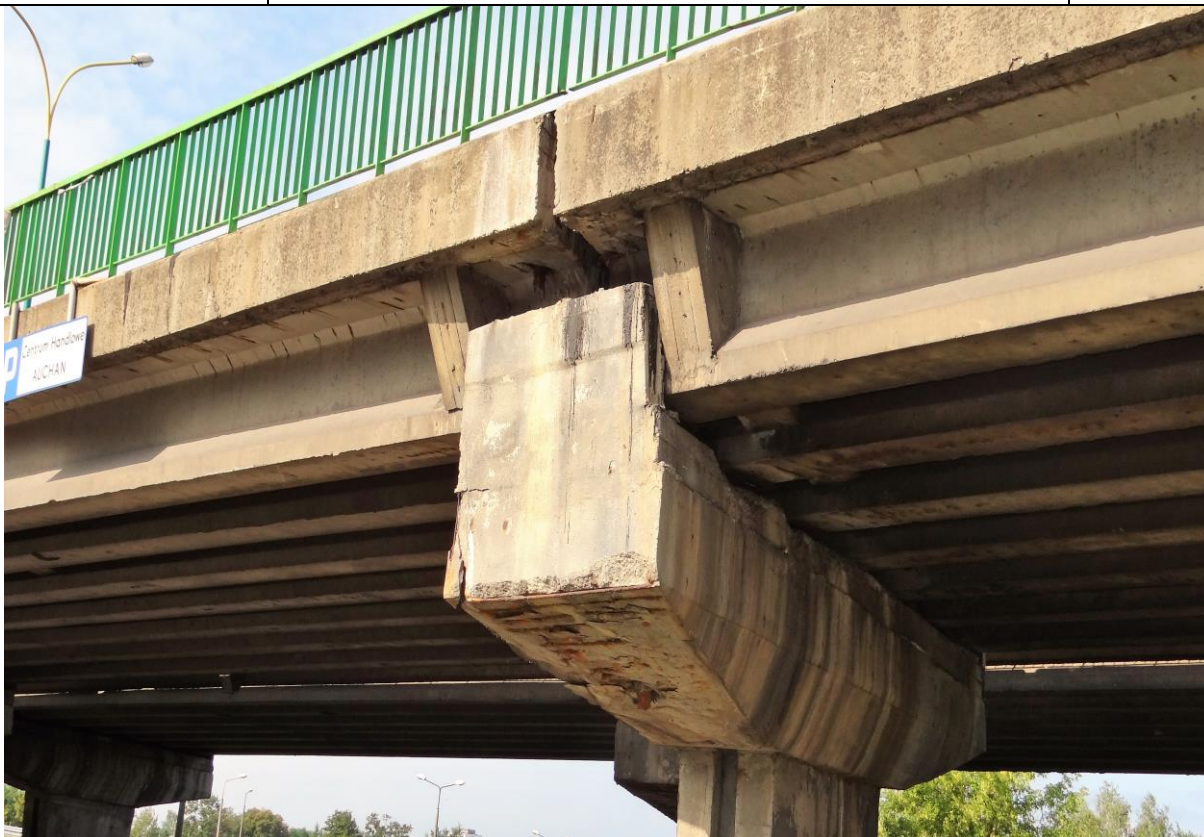
Fot. nr 1. Widok z boku: oparcie belek na oczępie filara.
