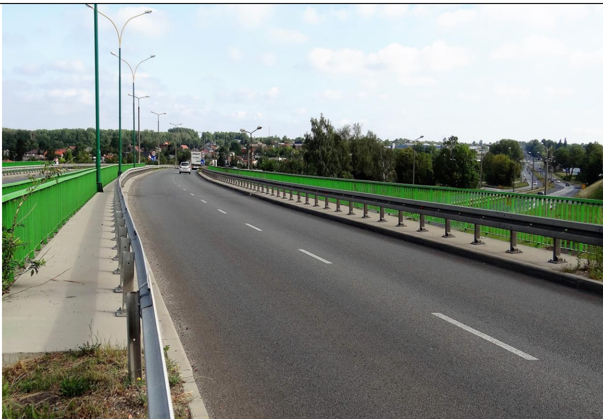
Fot. nr 2. Jezdnia na wiadukcie.
