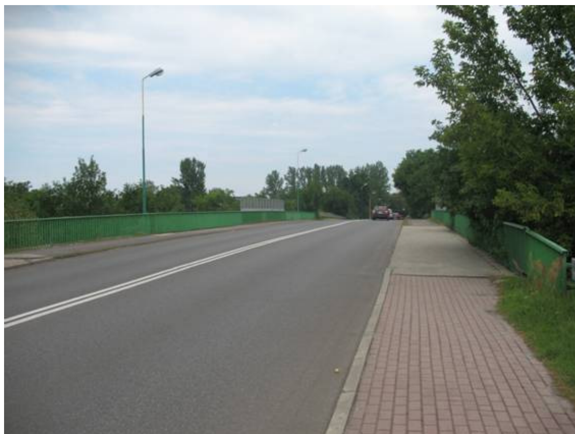
Fot. 2. Widok pomostu na dojazd od strony północnej.
