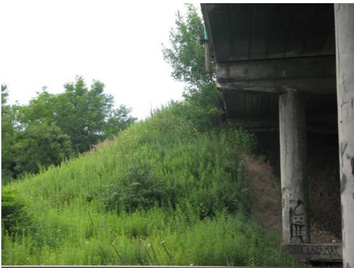
Fot. 6. Widok na stożek skarpowy od strony północno-zachodniej. Wegetacja roślin na stożku skarpowym.
