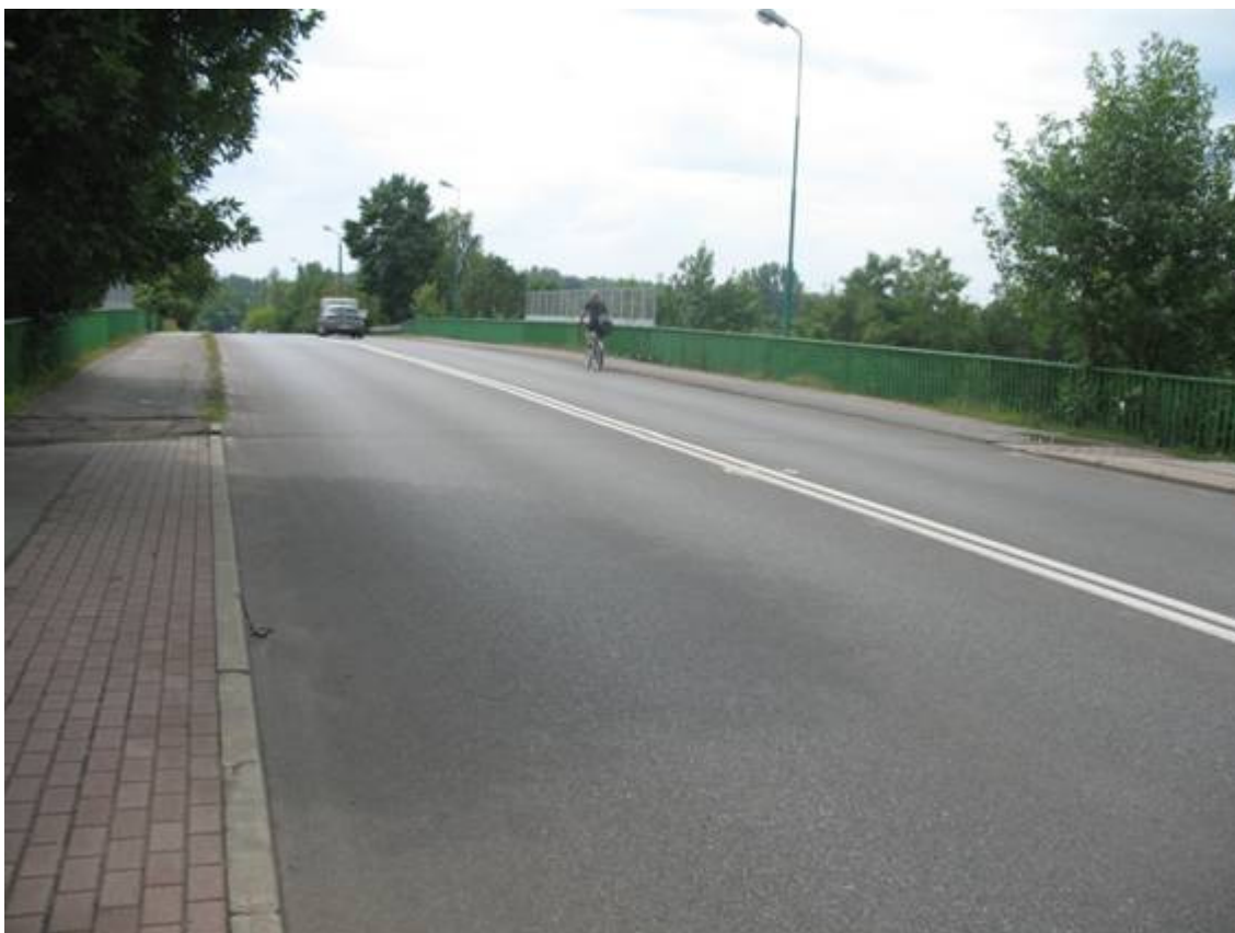
Fot. 1. Widok pomostu na dojazd od strony południowej.
