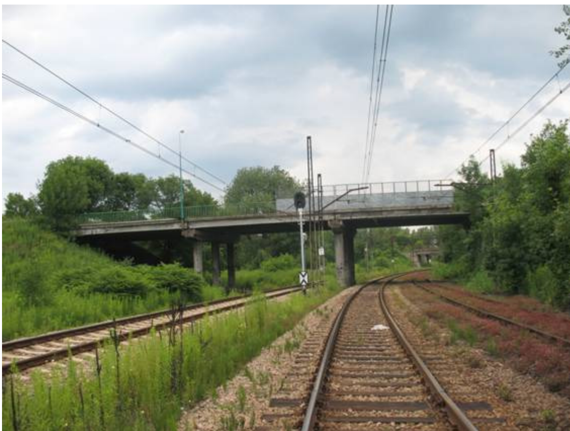
Fot. 4. Widok obiektu z boku od strony wschodniej.
