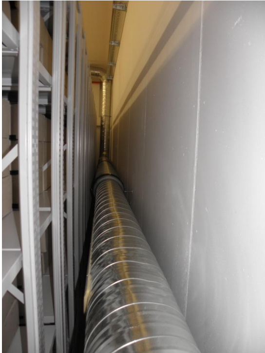
Wentylacja magazynów – nawiew zlokalizowany na wysokości 50 cm od podłogi prostopadle do regałów
