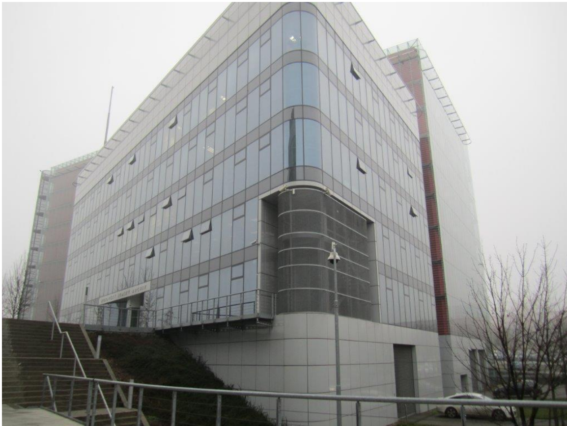
Widok na część administracyjno-biurową, z tyłu segment magazynowy
